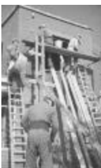
Voorgevel metsen (2013deel2(328))
