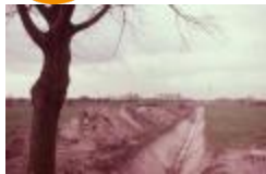
Aanleg verkaveling, lembeekse bossen (Spanhove2013053)
